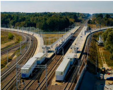
波兰E75铁路项目
