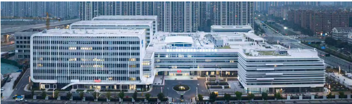
公司设计采购施工（EPC）总承包的良渚医院整体迁建项目荣获2025年度国家优质工程奖
