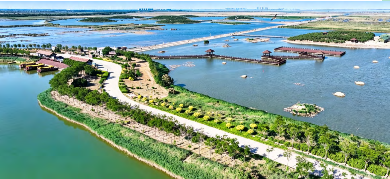
南大港生态修复项目以湿地生境改善为核心，通过退养还湿、河道疏通等工程，联通内部水系，构建“一核、二区、三带、多节点”的特色水系结构，增强水动力循环，有效改善生态环境
