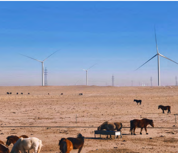
2025年9月，公司参建的国内单体规模最大陆上风电项目——内蒙古能源乌拉特中旗150万千瓦风储基地项目正式投入商业运行
