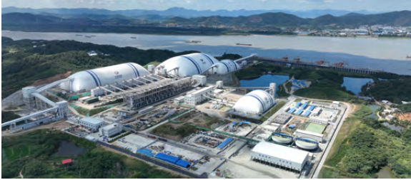
蕲春石鼓冲绿色建材基地项目以“减员、降耗、提安”为核心推进智慧矿山建设，部署厂矿级智能管控平台
