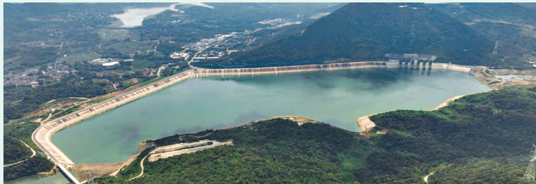
公司设计承建的江苏句容抽水蓄能电站
