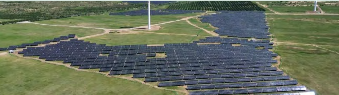
公司参与建设的内蒙古多伦15万千瓦风光储制氢一体化示范项目
