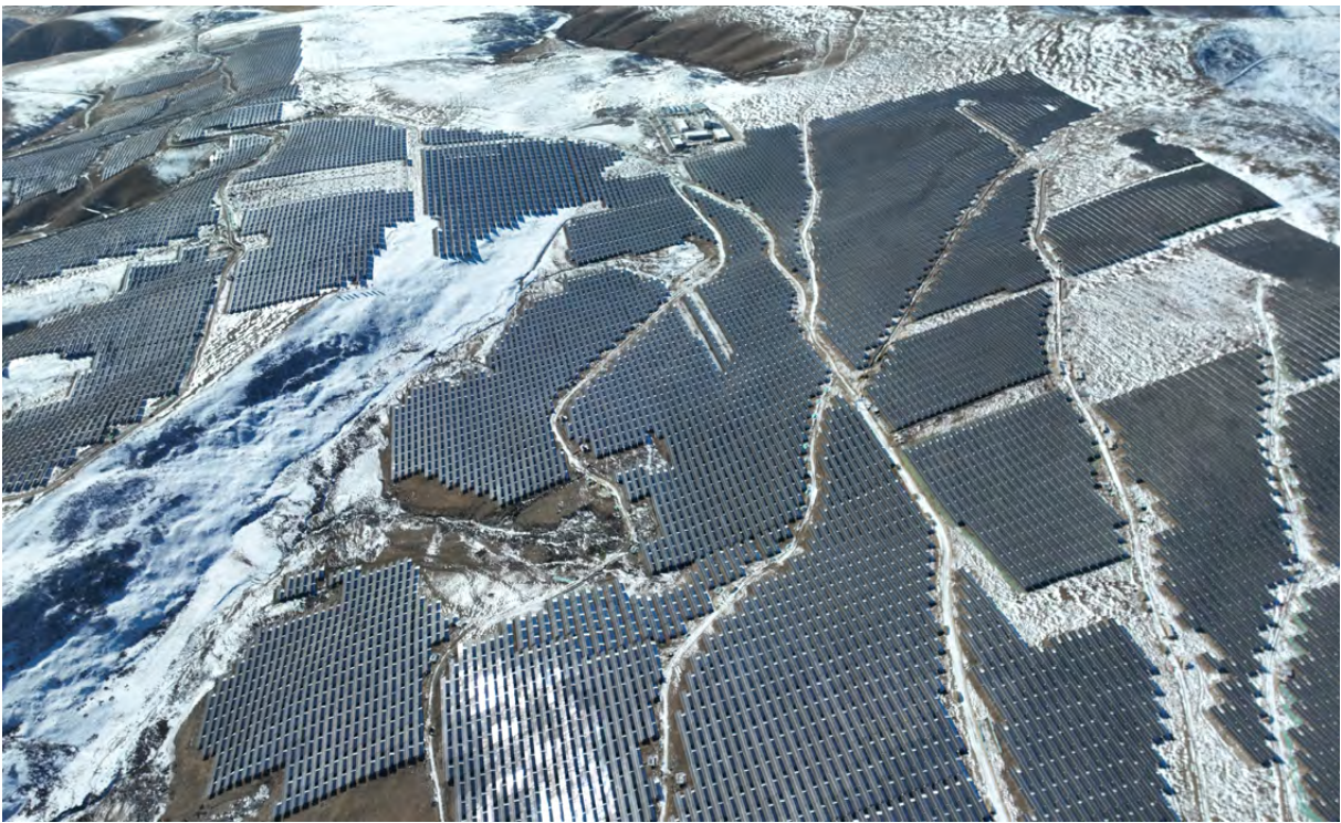
公司参与总承包的世界最大水光互补项目重点工程——索绒光伏项目并网发电，标志着百万千瓦级世界超高海拔清洁能源项目取得关键进展
