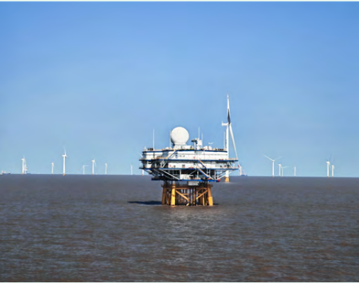
公司设计建设的大丰800兆瓦海上风电项目
