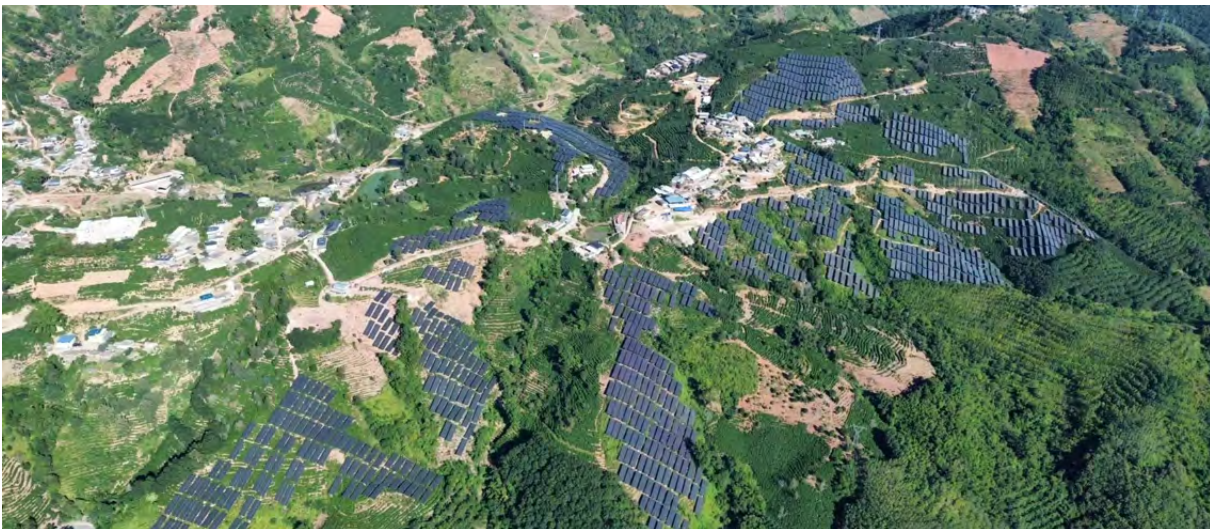
云南省普洱市思茅区咖啡厂复合光伏发电项目是全国实施的第一批“咖光互补”项目，“光伏+农业”模式提高了土地资源的利用效率，为区域就业、农民增收、农业提质增效等创造了有利条件
