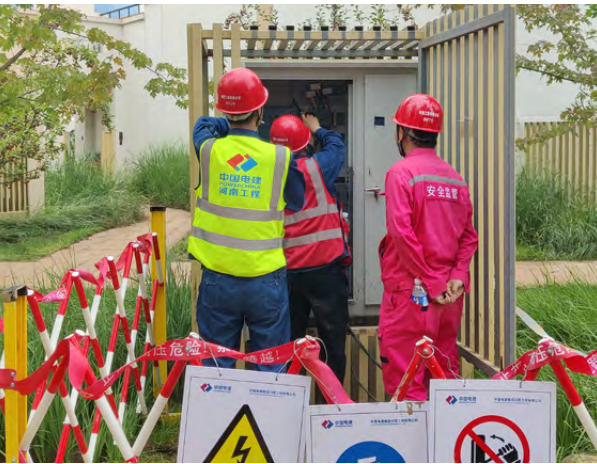
河南工程公司驰援河北承德兴隆县暴雨灾区，恢复受灾现场正常供电
