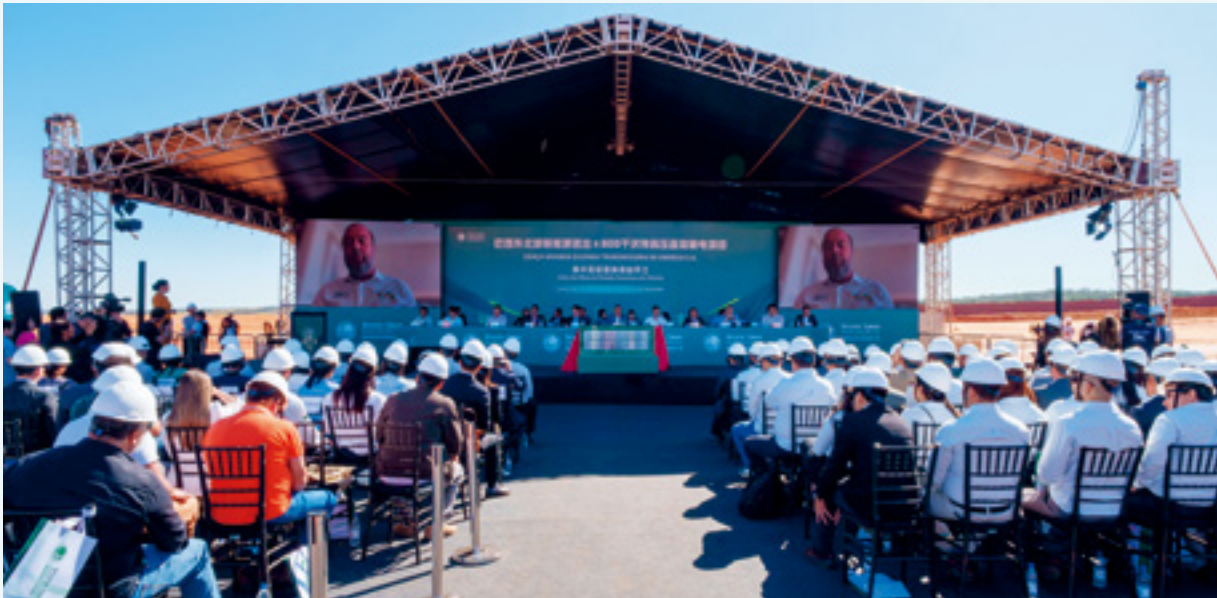
国网巴西控股公司实施的巴西东北部新能源送出 ±800 千伏特高压直流输电项目受端席尔瓦尼亚换流站开工。
