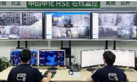
公司 HSE 在线监控室
