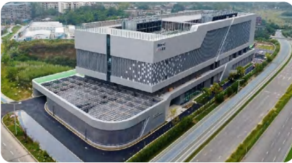
成都天府国际空港新城区域能源站
