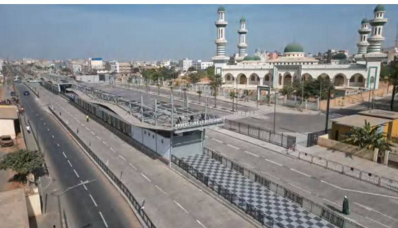
BRT 项目车站光伏板
