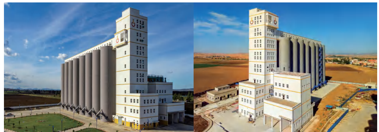
九个钢筋混凝土筒仓远景
