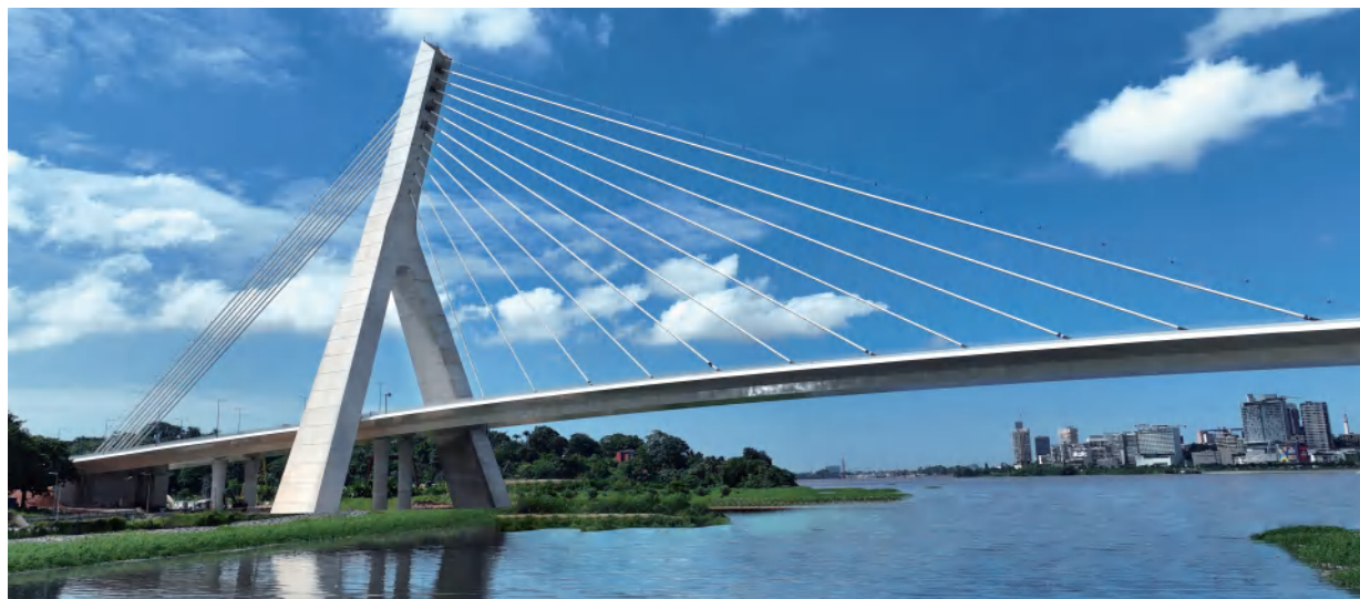
科科迪斜拉桥远景
