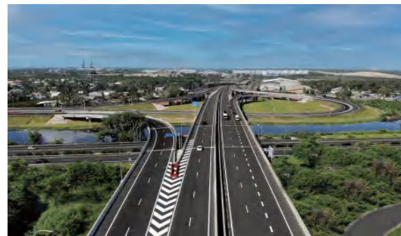
项目完工全景图
