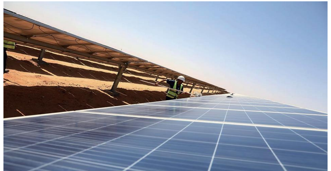
员工清洁光伏表面灰尘
