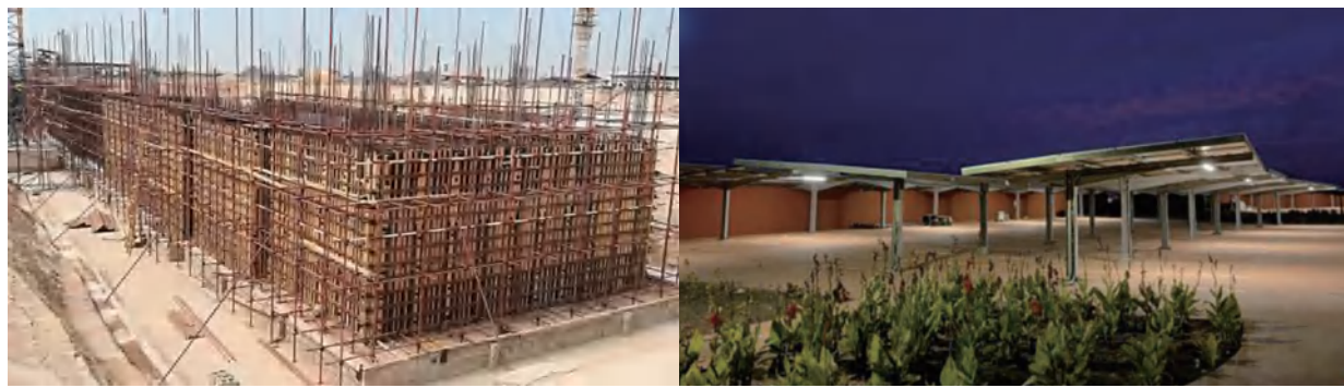
挡土墙模板标准化施工、利用室外太阳能光伏板下空间建停车棚
