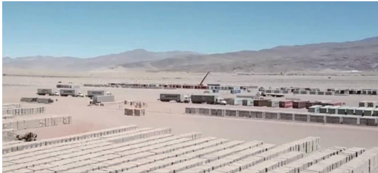
采购设备部署阶段现场图
