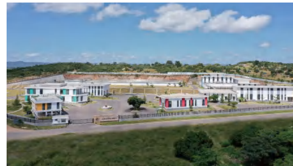
赞比亚卡夫河供水项目完工航拍图
